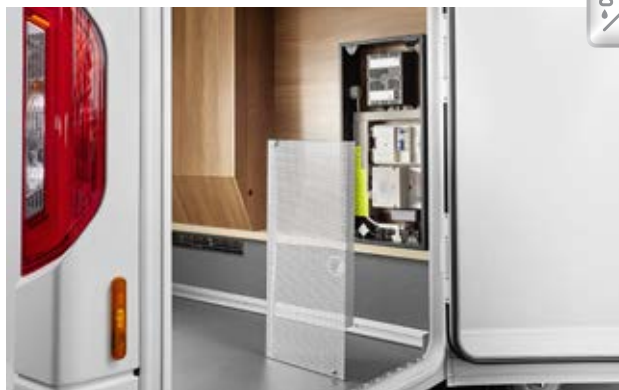
Elektrocentrale in scootergarage goed toegankelijk
