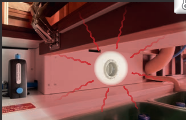
Warmeluchttopslagverwarmingstechniek Truma Combi 6 met groot aantal warmeluchtopeningen overal in de kelder van de dubbele vloer, in de woonkamer, in de scootergarage en bij de koudegevoelige toegangsdeuren.
