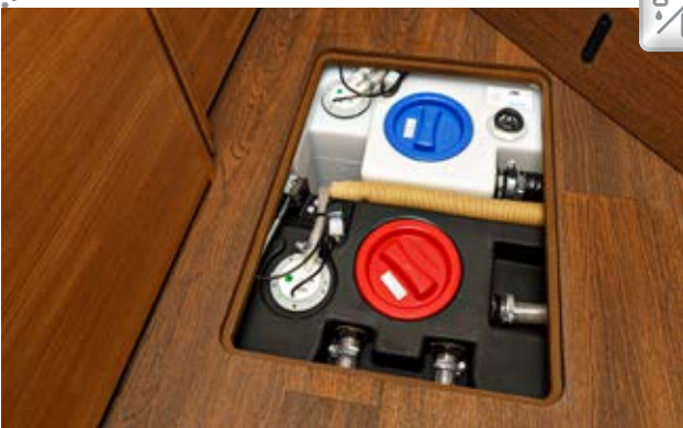
Serbatoi dell'acqua posizionati al sicuro dal gelo nel doppio pavimento riscaldato
